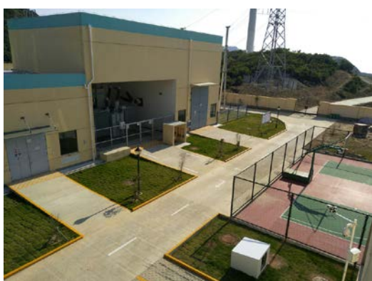
升压站绿化现状
